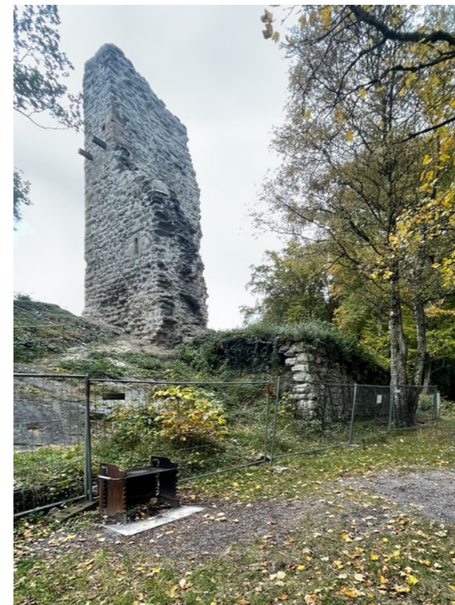
Abb. 24: Die Ringmauer wird zum Teil wieder erstellt und saniert.
