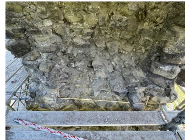
Abb. 12: Vorbereitung und Vermessung der Bruchkante
