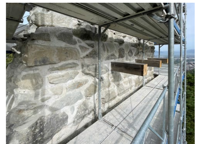
Abb. 17: Neue Eichenbalken Südfassade
