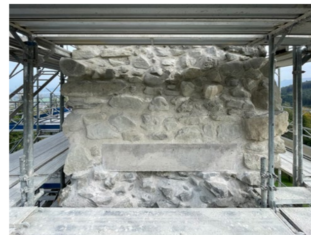
Abb. 14: Neuer Betonriegel
