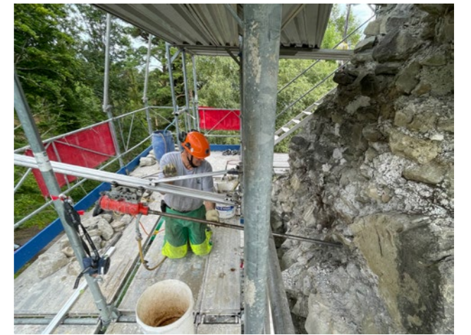
Abb. 13: Bohrung für Ankergewindestangen
