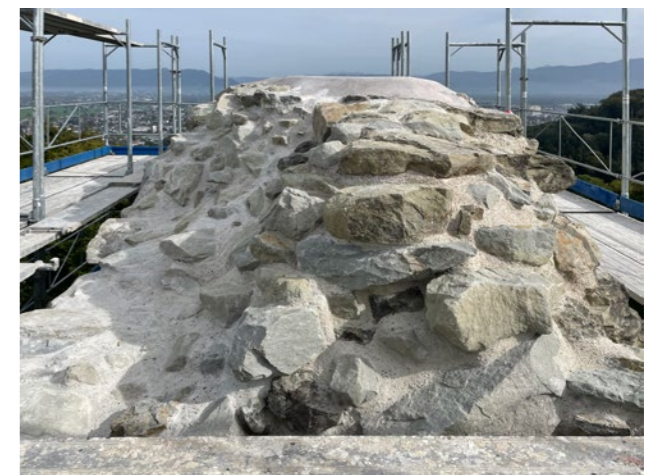
Abb. 15: Fertiggestellte Mauerkrone
