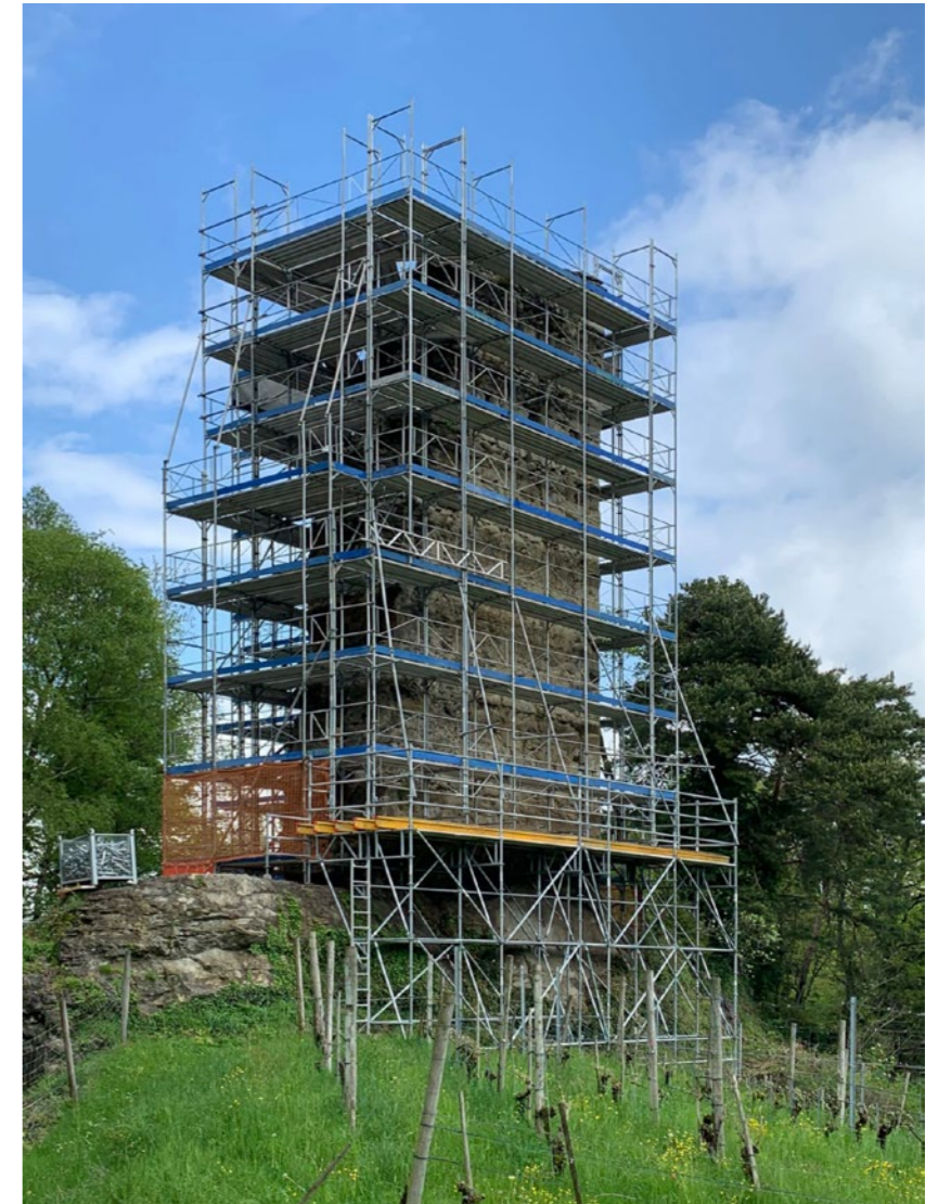
Abb. 6: Baugerüst 1. Etappe
