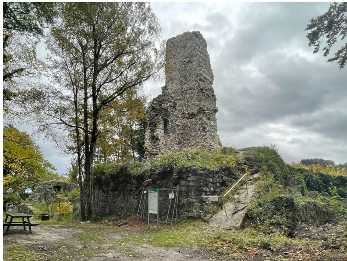
Abb. 22: Die zerfallene Grundmauer vom Turm wird saniert.
